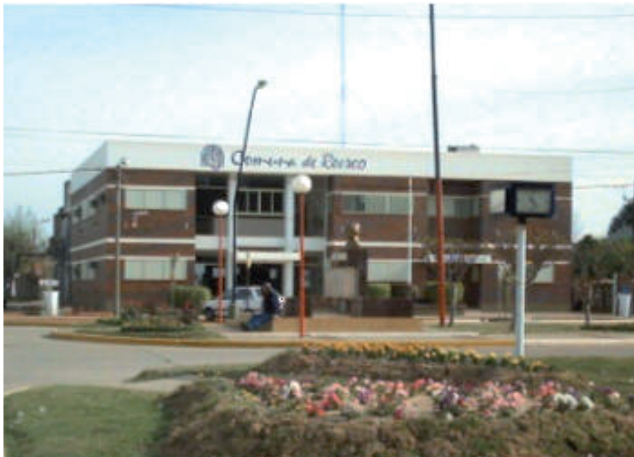
Edificio comunal (foto: Marcelo Pittilini)
